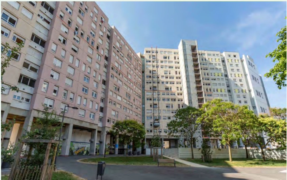
Logements sociaux aux Villeneuves – Crédit : Grenoble-Alpes Métropole
