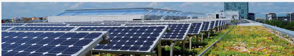
Toit PV vert (Système Heliogreen) – source : https://www.ecovegetal.com/toitures-vegetales/heliogreen-photovoltaïque
