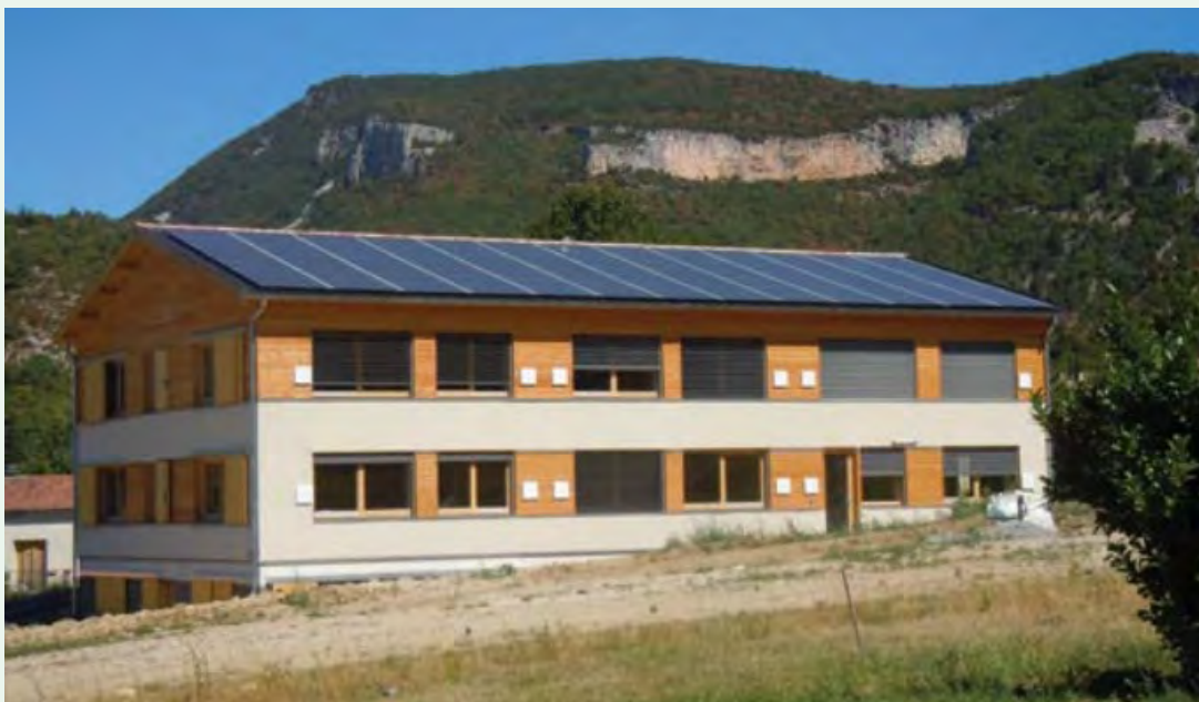
Bâtiment LowCal d'Enertech – Crédit : Enertech
