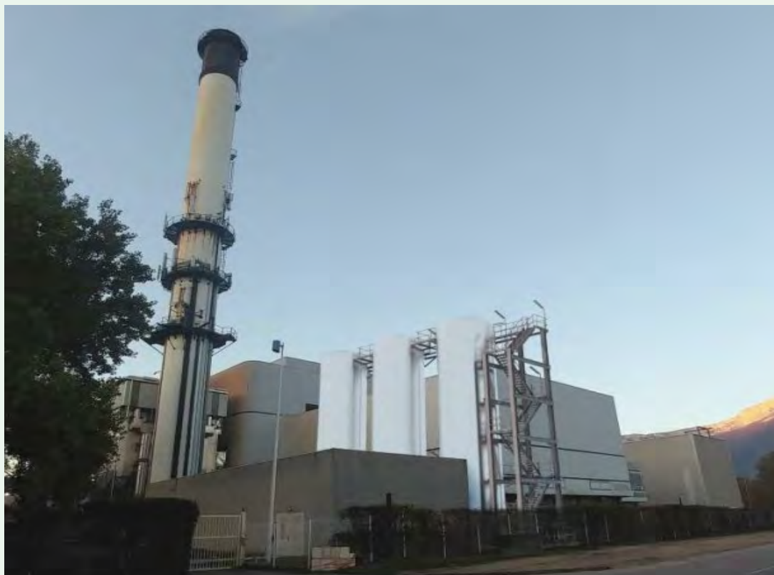
Citernes de stockage d'eau chaude
