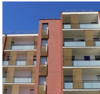
▲ Port-de-Bouc – 481 logements réhabilités et 25 créés
