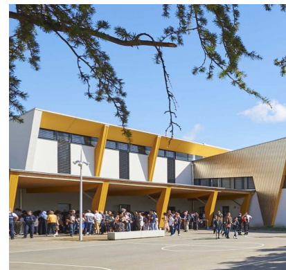
▲ Restructuration et agrandissement de l'école Adélaïde Hautval dans le quartier Libermann à Illkirch-Graffenstaden
