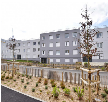
▲ La Roche-sur-Yon – 544 logements réhabilités dans le quartier de la vigne aux roses, avec déconstruction-reconstruction de la chaufferie collective
