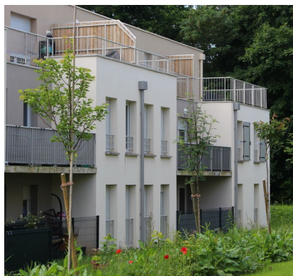
▲ Beauvais – Construction de 35 logements locatifs de Clésence (du groupe Action Logement)
