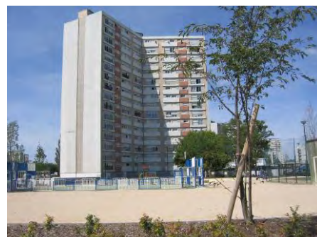
Aire de jeux en pied d'immeuble
