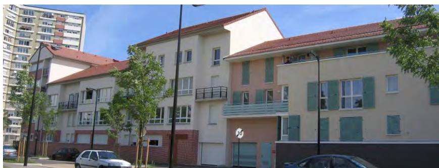
L'imbrication des styles sur un même linéaire de façade
