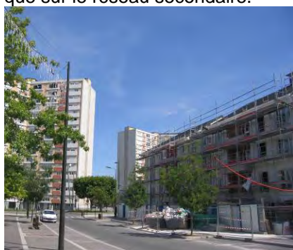
Façades sur axe majeur
