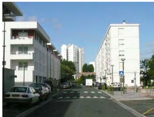
Haut-Carriet Est : A droite les HLMO anciens, à gauche les PLUS CD, au fond, la tour réhabilitée
