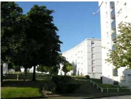
Le secteur du Haut Carriet sud : les immeubles Domofrance déjà réhabilités
