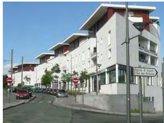
L'accession. Magasins au rez-de-chaussée
