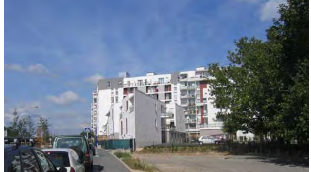
Plot d'angle et réhabilitation de l'ensemble situé en tête de quartier à l'ouest
