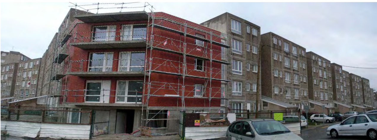
construction en cours d'un plot d'angle
