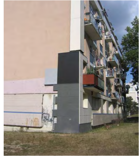
Essai de revêtement pour le traitement des pignons
