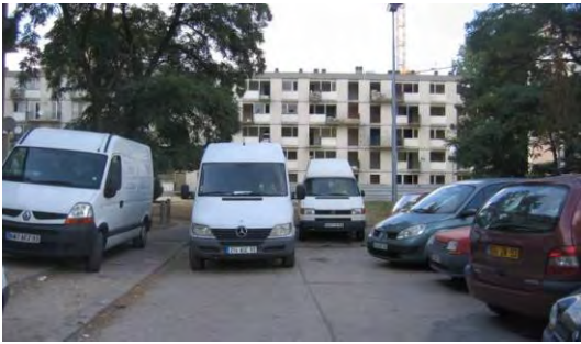
La recomposition de la trame urbaine prolongement de la voie existante et la démolition d'une portion de la barre
