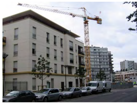
Immeuble en limite de site, constitutif de la façade urbaine
