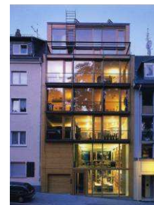
Un bâtiment de bureaux - logements, Wiesbaden, A-Z Architekten.
