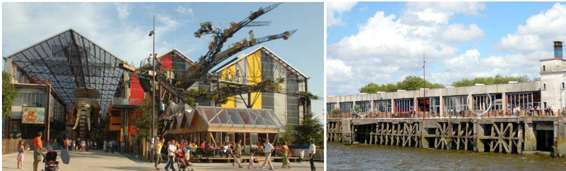
Réhabilitation de bâtiments industriels en projet culturel, équipement commercial, dans le cadre du projet urbain de l'île de Nantes.
